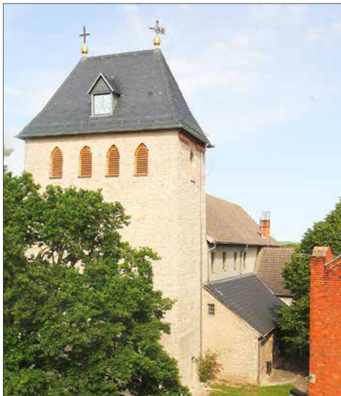
Der neu sanierte Kirchturm der evangelischen Kirche St. Peter und Paul in Wegeleben mit neu gedecktem Dach, Schalllucken, Fledermaus-Nistkästen, sanierter Bekrönung und sanierter Fassade
