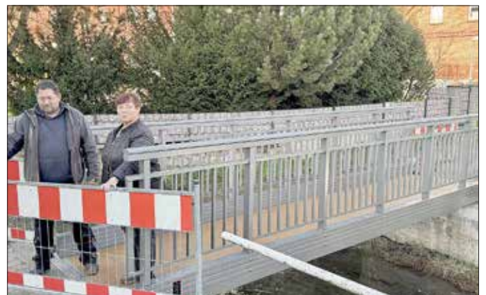
Bauhändler Ulrich Rudzinski und Harslebens Bürgermeisterin Christel Bischoff sind froh, dass das Problem Goldbachbrücke jetzt gelöst ist. Foto: Dieter Kunze
